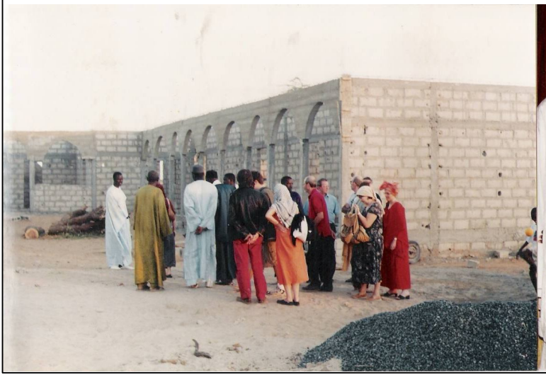
معهد الأزهر بدار السلام اندام في طور البناء
